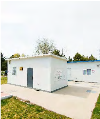
大连科兴污水处理站
